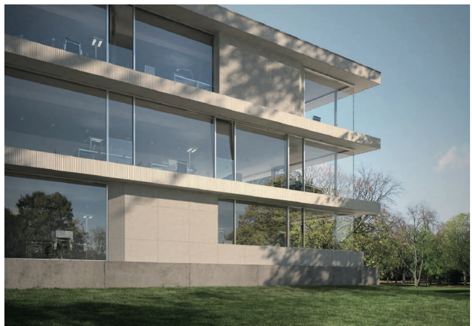
Edifício construído com Perfil Schüco FWS 60 CV
