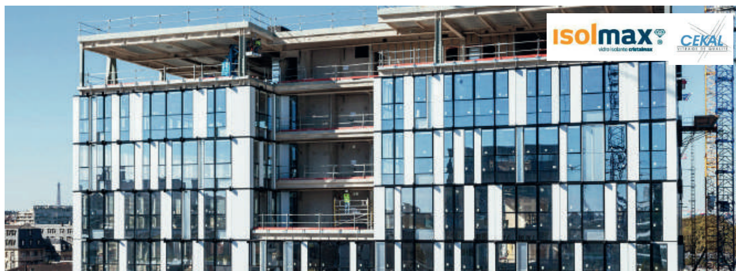
A9a2 Zac Rive Gauche - Paris: fornecimento de 10.000m2 de fachadas em vidro isolante ISOLMAX® em Antélio Argent e Laminado Planitherm XN acústico incluindo colagem VEC
