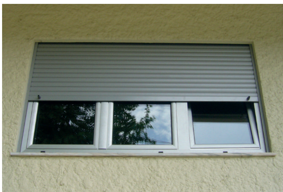
Obra de renovação
