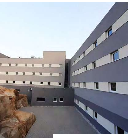
Caixilharia da F2J no novo Hotel de Matosinhos
