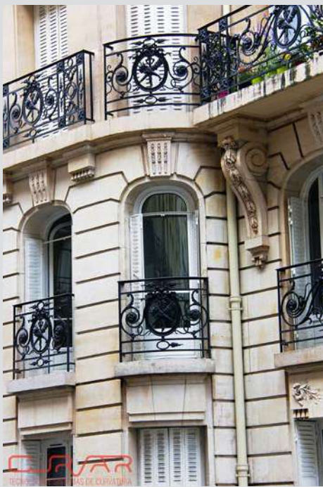
Reabilitação de edifício - Paris
