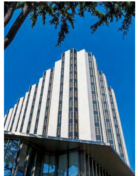
Obra CROWNE PLAZA
