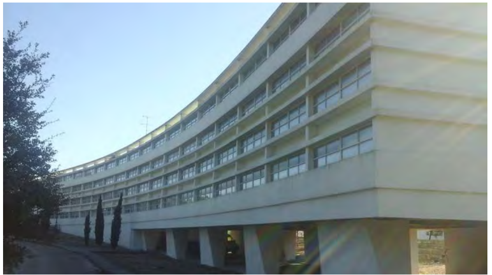
Obra de remodelação da ESAD
