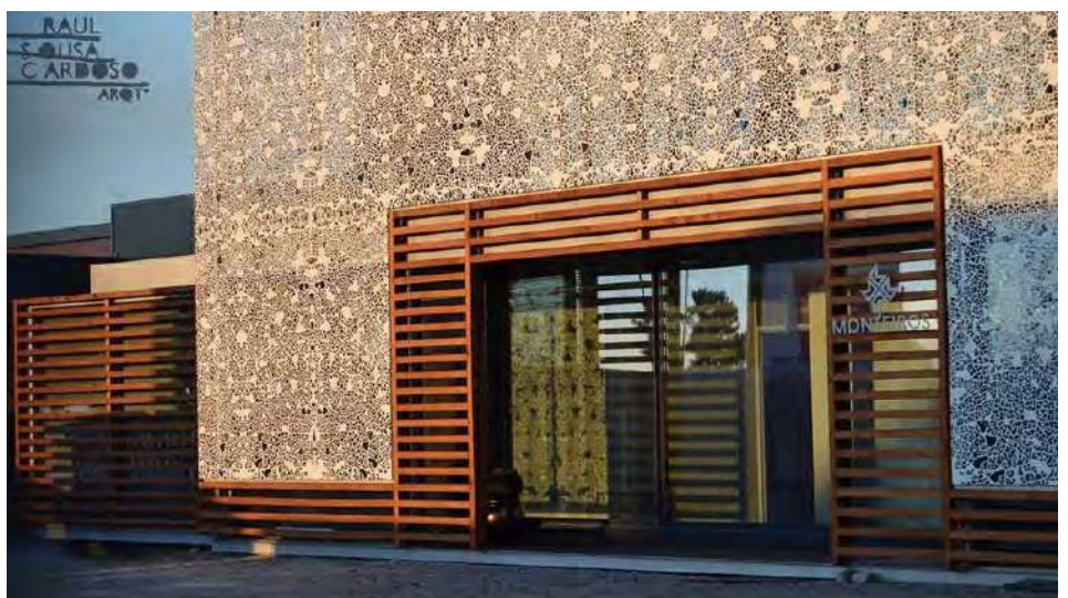
Fachada da empresa MONTEIROS
