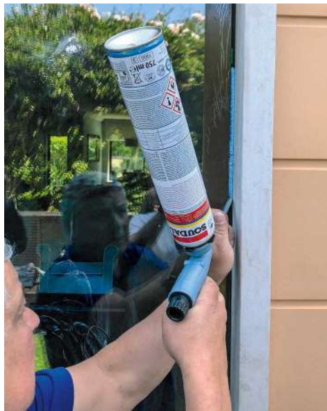
Os sistemas da Soudal asseguram que a zona de ligação janela-parede também seja eficiente
